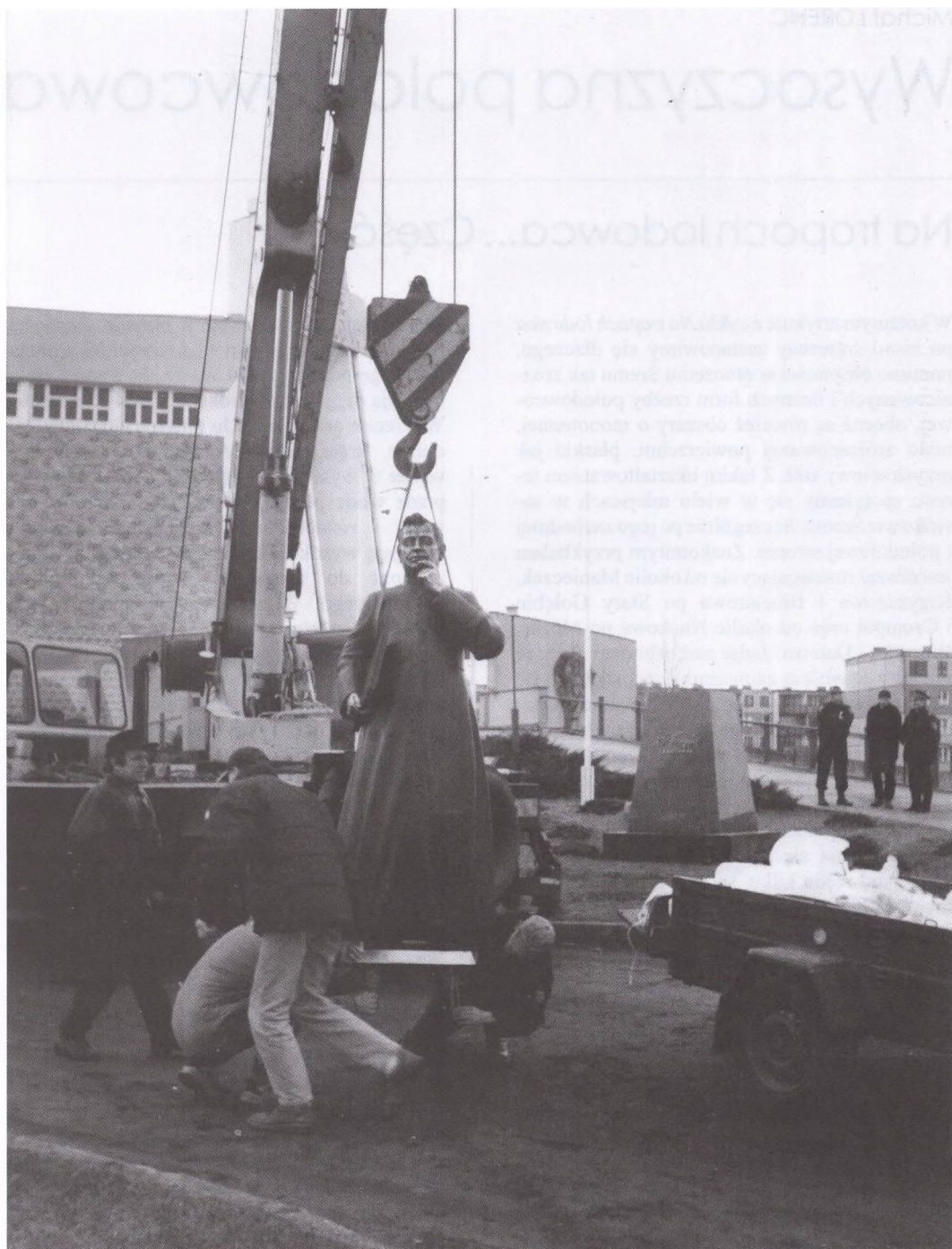
Montaż rzeźby na cokole
