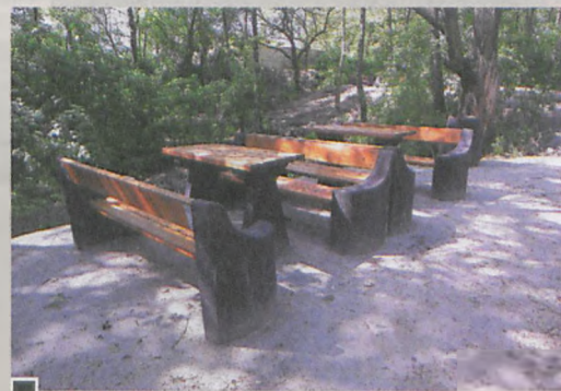
Ciekawe, w jakim stanie będzie ścieżka rowerowa i zainstalowana na niej infrastruktura po powodzi fot. Paweł Jankowiak
