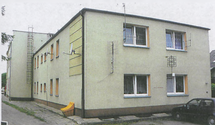
Blok przy ul. Sobieskiego 59 (stara szkoła – budynek II wybudowany w 1913 r.), w głębi przyklejony budynek 59 a (stara szkoła – budynek III z 1931 r.) Pomimo ciągłego wietrzenia z zagrzybionych mieszkań wilgoci nie można usunąć fot. Piotr P. Ruszkowski
