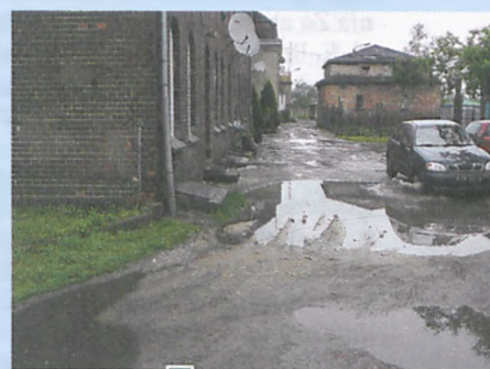
Na zdjęciu wejście do budynku mieszkalnego Spółdzielni Mieszkaniowej Spójnia przy ul. Armii Poznań 41. Nie można tu przejechać suchym kołem, a co dopiero bezpiecznie przejść. Na drugim planie widać budynek gospodarczy, w którym być może z powodu nadmiernej wilgoci wyrosło okazałe drzewo (ulistnione gałęzie jego korony są widoczne na dachu) fot. Paweł Wolniewicz
