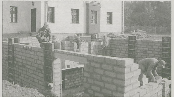
NA PLACU BUDOWY W DPS-ie w Zakrzewie pracuje 30-osobowa ekipa firmy „Rem-Bud”. Jeden z jej właścicieli - Ryszard Grzebyszak zapewnia, że termin zakończenia robót - 20 grudnia, zostanie dotrzymany.
