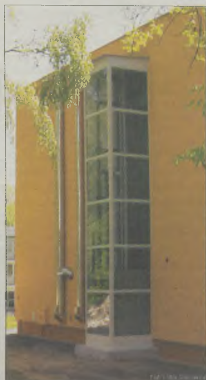
BUDYNEK przy ulicy Jarocińskiej po adaptacji został wyposażony w podjazd i windę dla osób niepełnosprawnych
