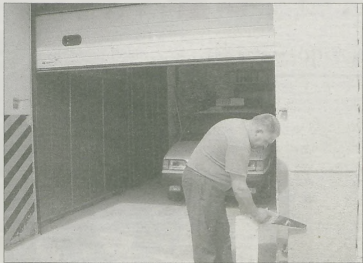
STRAŻACY sami remontują budynek OSP w Jaraczewie
