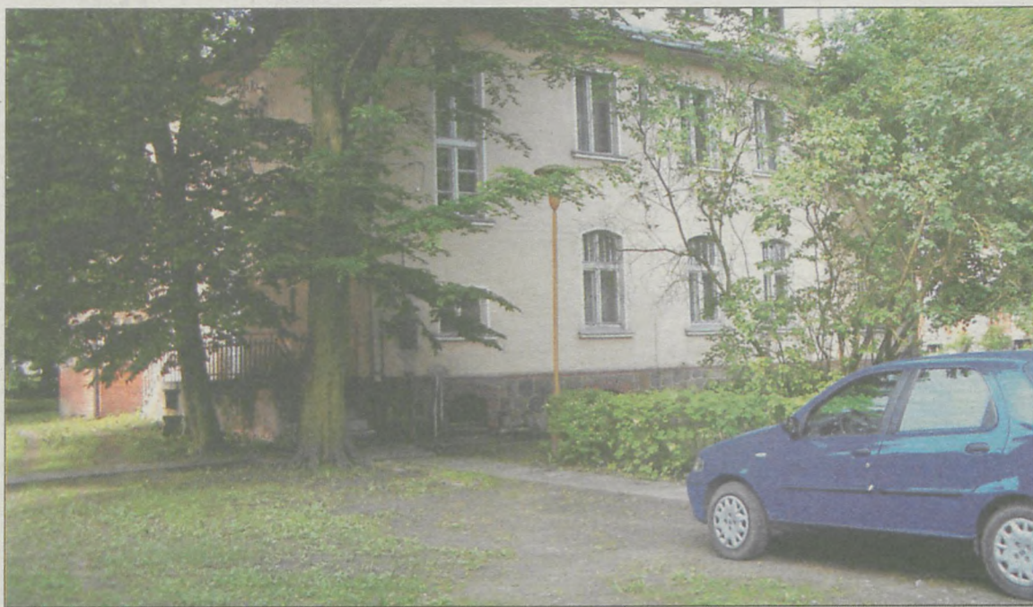
GENERALNE REMONTY w ośrodku w Cerekwicy rozpoczną się od budynku, który znajduje się tuż przy wjeździe do placówki
