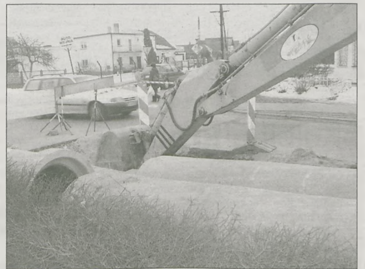
BUDOWA KANALIZACJI DESZCZOWEJ skutecznie utrudnia ruch na ul. Wrocławskiej
