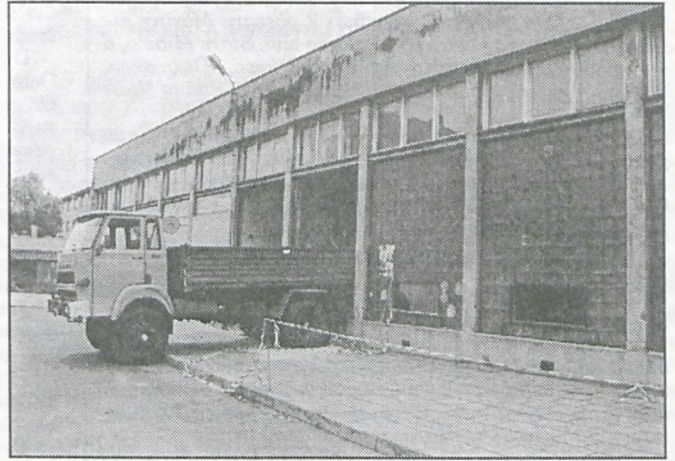
Czy to garaże w SPZ? NIE! To przebudowa świetlicy na salę gimnastyczną
