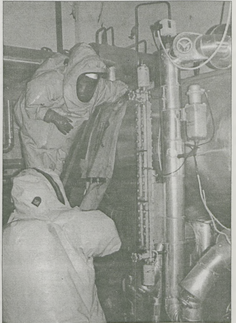
Zabezpieczanie wycieku amoniaku
