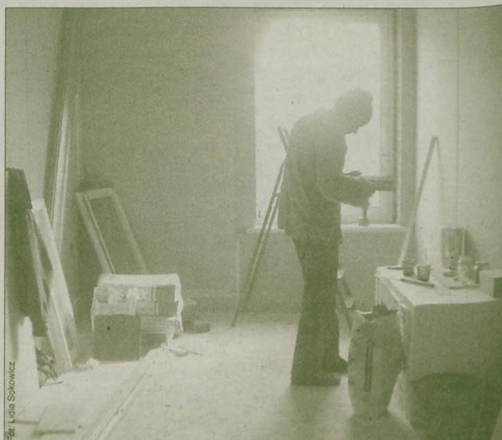
DZIĘKI PRZEBUDOWIE w Urzędzie Stanu Cywilnego powstaną nowe pomieszczenia biurowe
