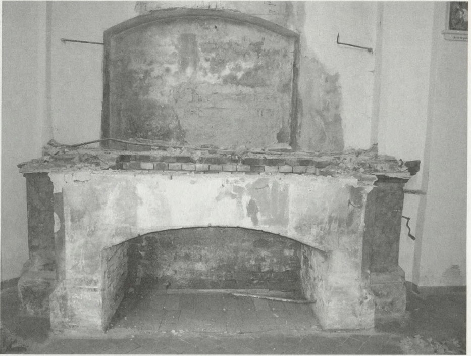
7. Kościół w Kórniku, wewnętrzna elewacja trzeciego przęsła nawy północnej. Na pierwszym planie rozebrana w 2004 r. mensa ołtarzowa, za nią wnęka podokienna z XV w., przemurowana w XVIII w. (1737?). Fot. P. Grabowski, 2004 r.
