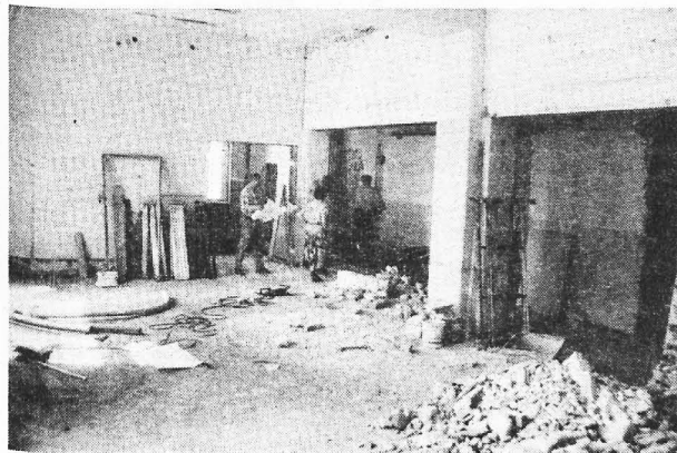
Największe roboty remontowe wykonywane są w szkole w Witaszyczach
